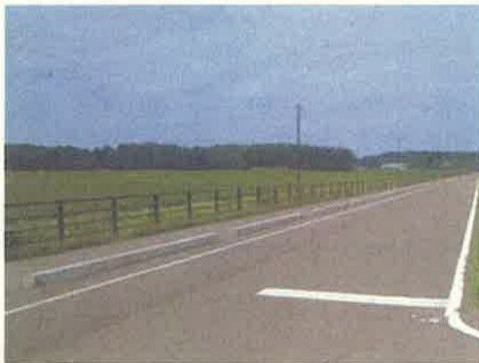
市道 浮島中坪線 上越市三和区浮島
